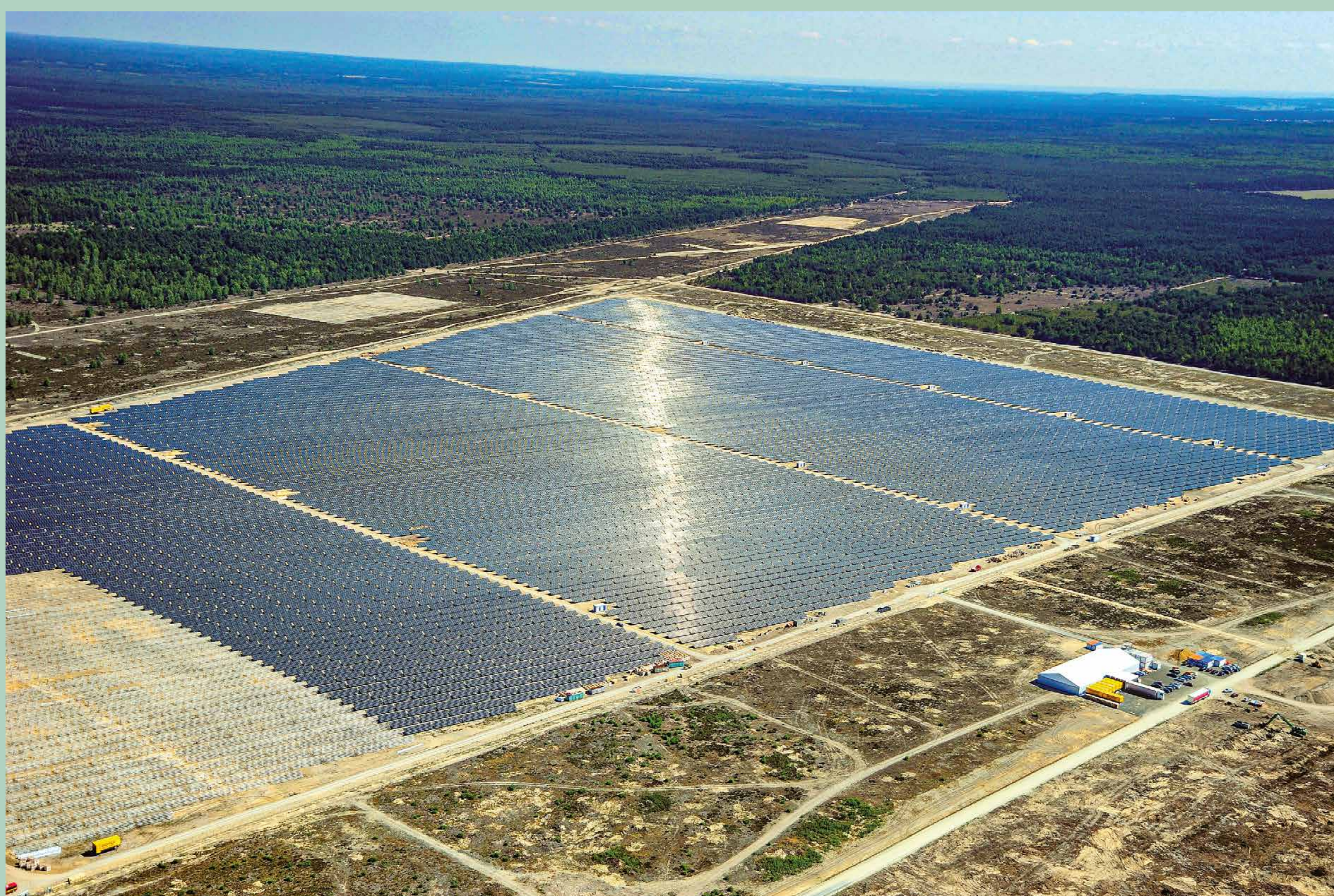
Bau der Photovoltaik-Anlage in Turnow-Preilack, Fotos: Procon GmbH
