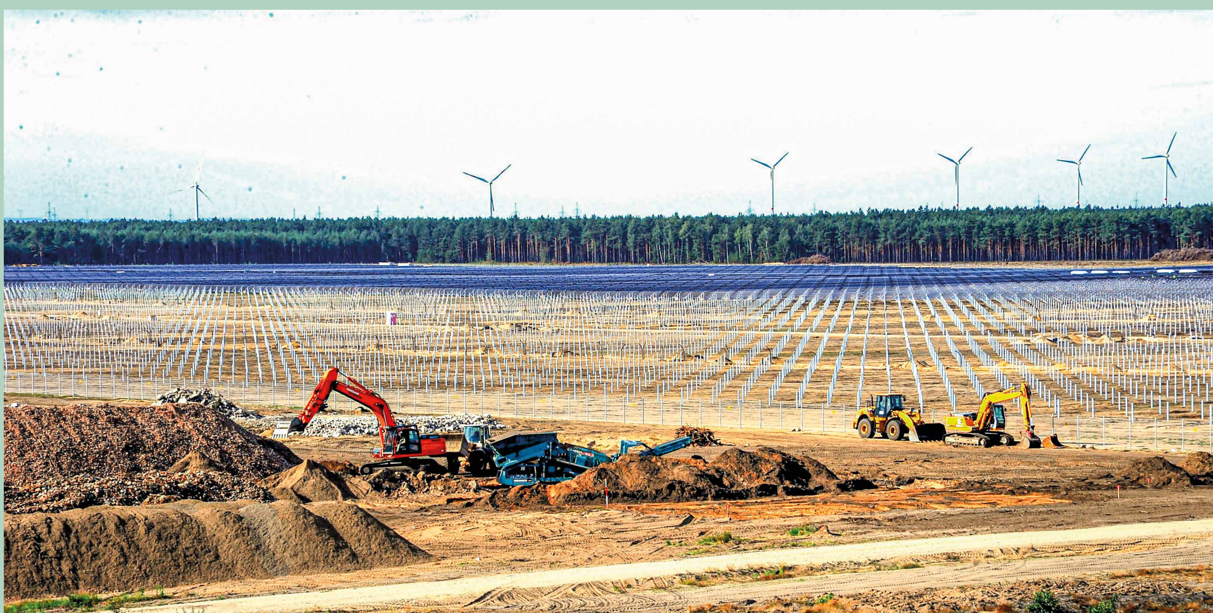
Bau der Photovoltaik-Anlage in Turnow-Preilack, Foto: Procon GmbH
