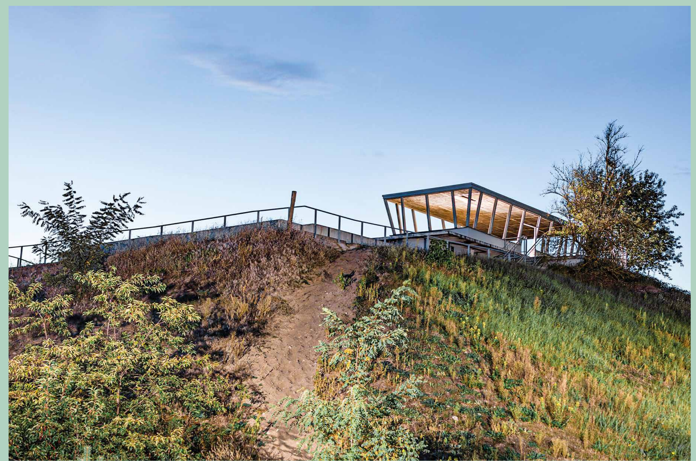
Zustand im Jahr 2024. Foto: Tomasz Lewandowski
