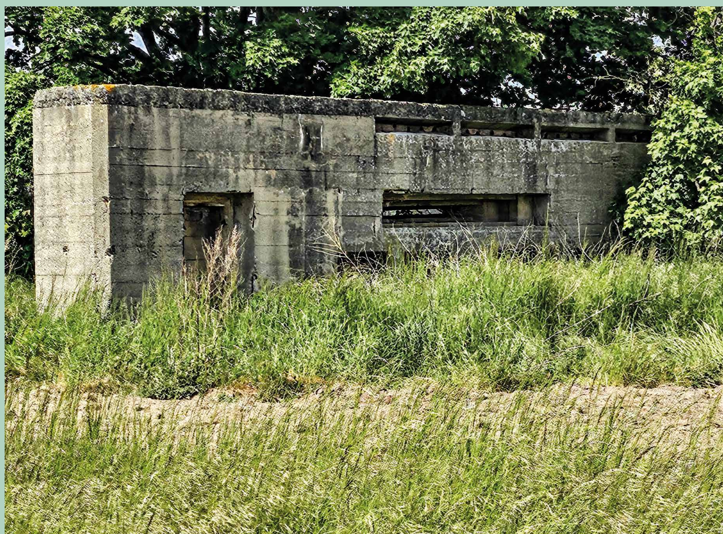
Zielschießanlage zur Vernichtung von Panzern bei Leeskow. Errichtet 1944, Zustand 2025, Foto: H. Schirmer
